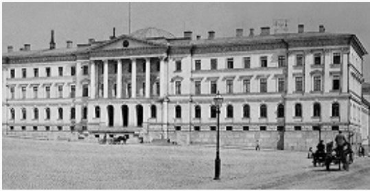
Здание Сената Великого княжества Финляндского. Гельсингфорс. Архитектор К. Л. Энгель. 1818–22.
