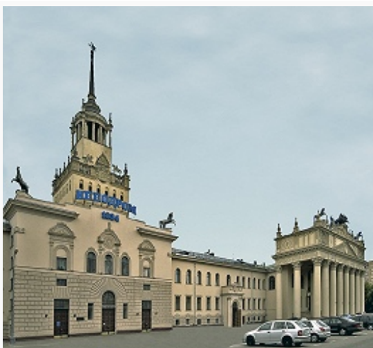
Здание Центрального московского ипподрома.
