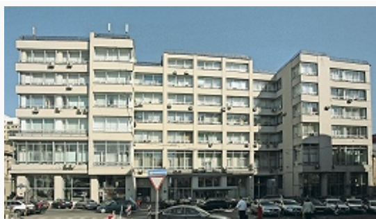
Здание Госторга в Москве. 1927. Архитекторы М. О. Барщ, Б. М. Великовский и др. Фото А. И. Нагаева
