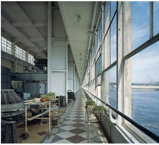
Интерьер машинного зала Днепрогэса. 1927–32. Архитекторы В. А. Веснин, Н. Я. Колли и др.
