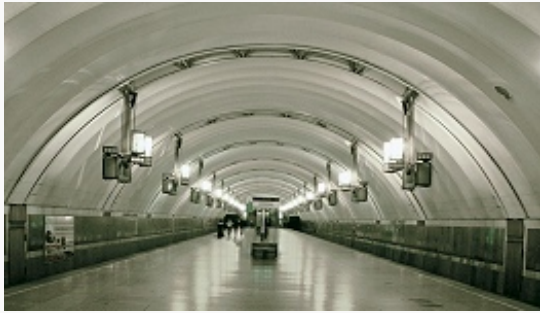
Рис. 4б. Станция «Лиговский проспект» (С.-Петербург).
