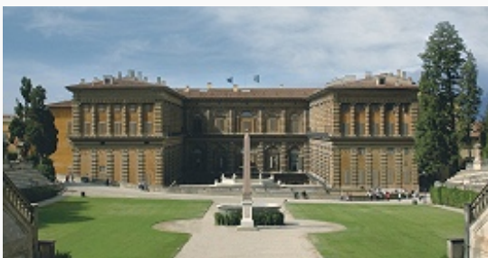
Палаццо Питти. Садовый фасад. 1560–77. Архитектор Б. Амманати.
