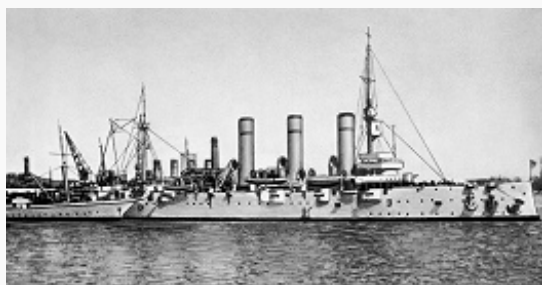
Крейсер «Аврора» во время ремонта у стенки Франко-русского завода. Петроград. 1917.
